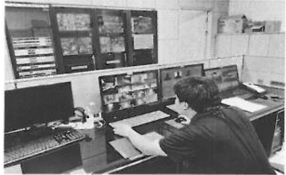
CCTV 각도 및 녹화 확인
